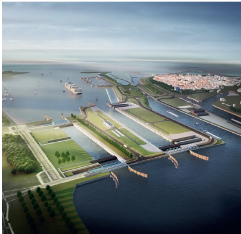
Die neue Schleuse soll die reibungslose Durchfahrt von Binnenschiffen zwischen den Niederlanden, Belgien und Frankreich und zudem eine zuverlässige Durchfahrt für Seeschiffe ermöglichen.
